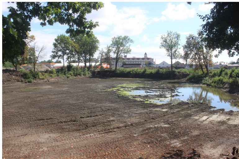
Terénní práce na rybníku, foto autor 6.8.2022.
