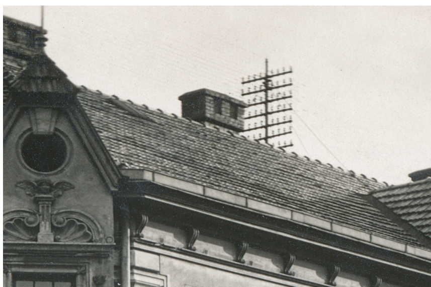
Výřez z pohlednice Sokolského domu v Holešově, na kterém je vidět konzole na střeše domu, která nahradila původní dřevěné sloupky v ulici. Zdroj: archiv autora.
