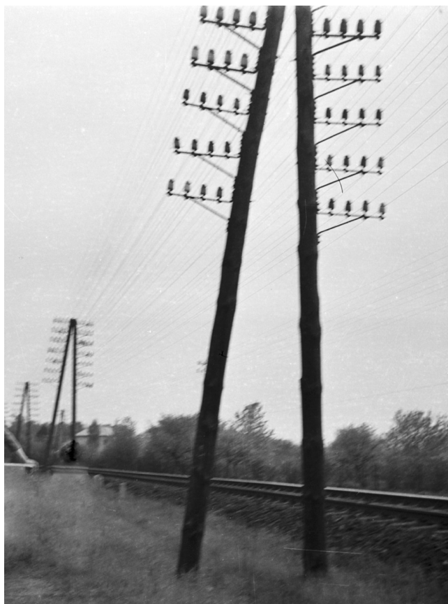
Telefonní a telegrafní sloupy lemující železniční trať Kojetín – Valašské Meziříčí. Záběr nedaleko Bezručovy ulice, který pořídil v 60. letech pan Arnošt Pospíšil.
