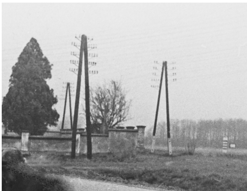
Další záběr z Třebětic, kde jsou vidět telefonní sloupky u silnice i u železniční tratě. Zdroj: archiv obce Třebětic.
